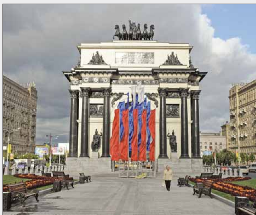
В Москве после реставрации открылась Триумфальная арка в рамках мероприятий, приуроченных к 200-летию Победы в Отечественной войне 1812 года. Реставрация на этом объекте не проводилась с 1968 года. В последние годы арка находилась в аварийном состоянии и стала разрушаться. Пришлось снимать с неё колесницу и скульптуру богини Ники, чтобы реставрировать их в специальной мастерской.
